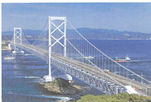
▲① 大鳴門橋 (ツーリズム四国 HP より)
